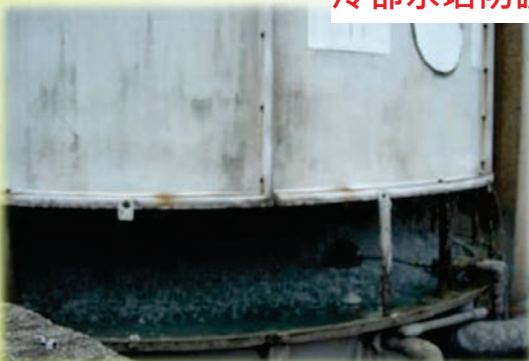
冷卻水塔防護網脫落未修護
