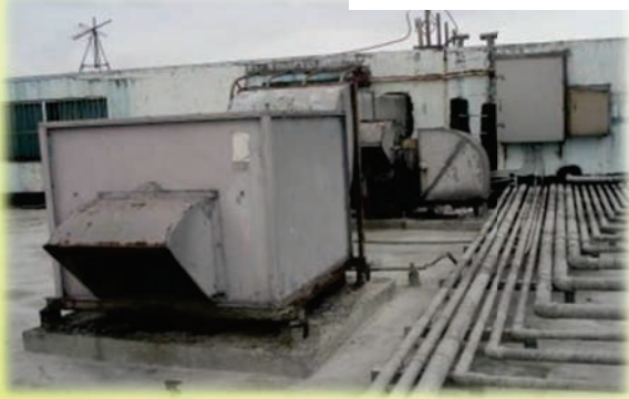
引入外氣口與管線生鏽、老舊且破損
