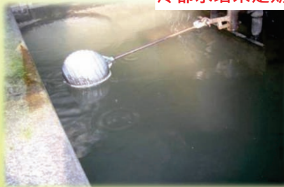
冷卻水塔未定期清洗投藥及制菌
