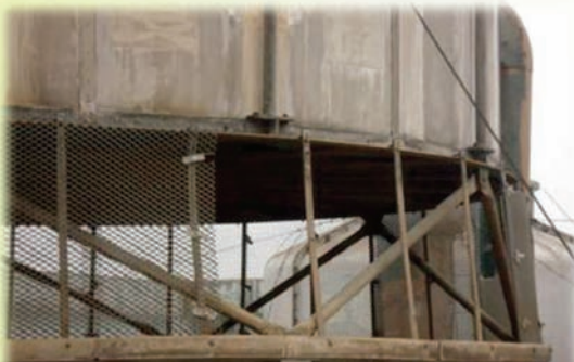
冷卻水塔防護網脫落未修護
