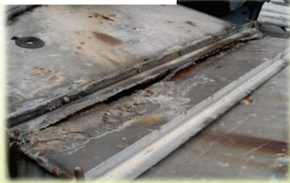
引入外氣口與管線生鏽、老舊且破損
