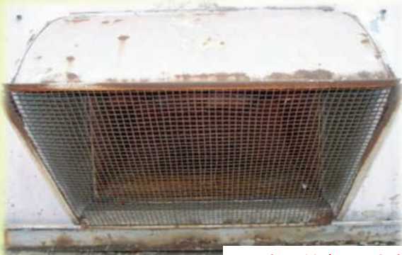
引入外氣口與管線生鏽、老舊且破損
