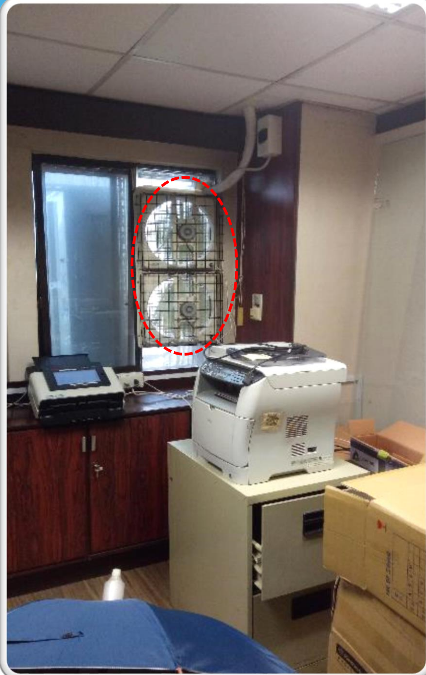
圖8.10 影印機獨立設置或採負壓排氣措施(續)
