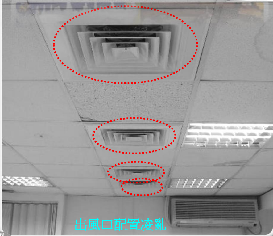
圖6.16 空調出、回風口配置位置與數量凌亂之情形
