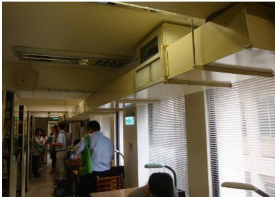
圖8.4 引入外氣直接進入落地型空調箱之改善案例
