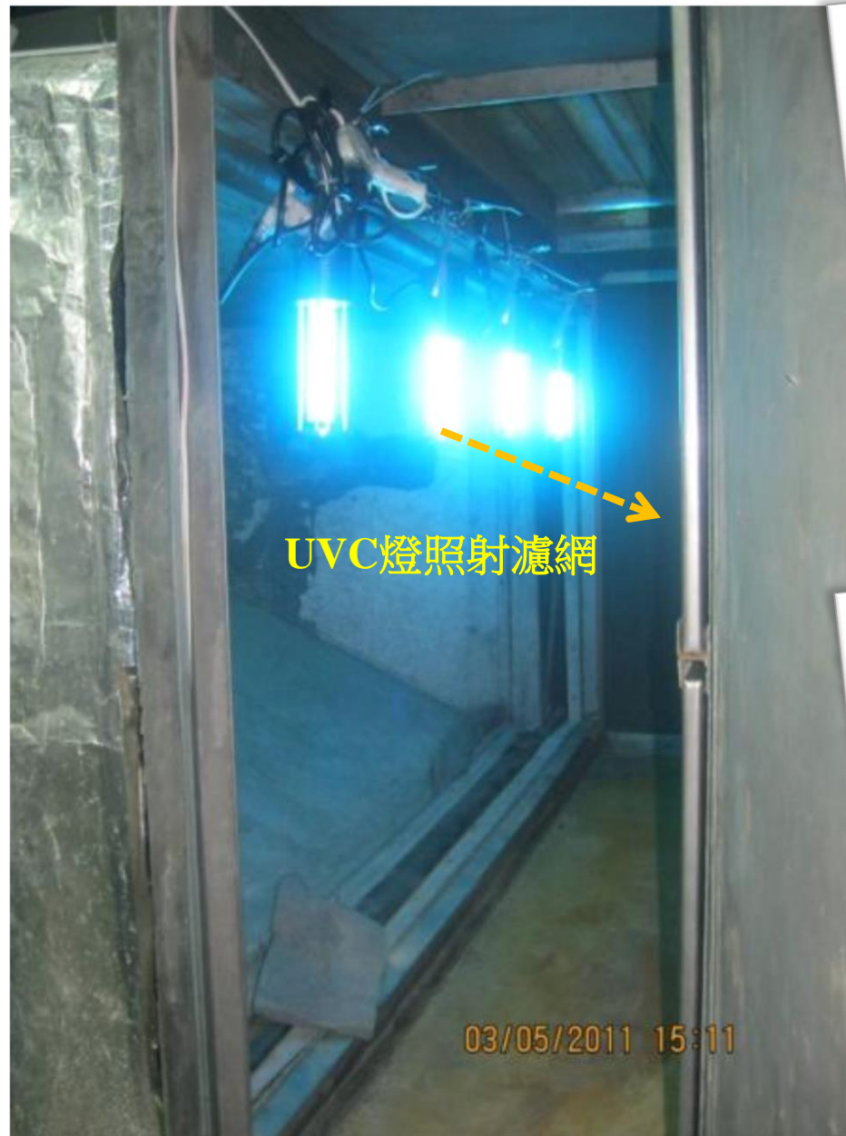
圖6.39 中央空調系統空調箱內UVGI淨化應用之實務案例
