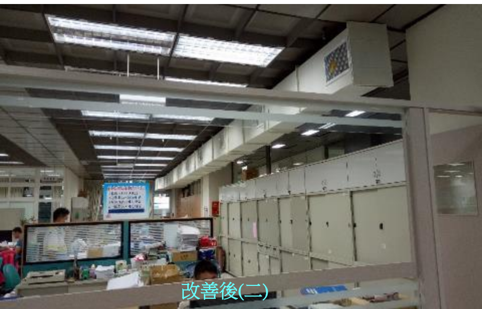
圖8.6 某市政府辦公大樓以預冷空調箱(PAH)引入外氣結合原空調系統之改善案例
