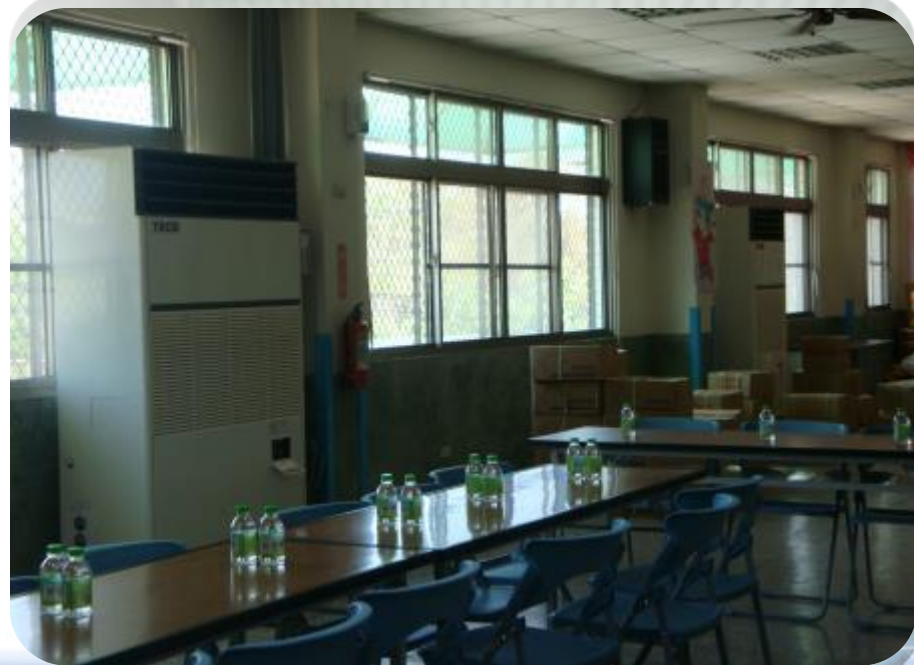
圖3.8 無外氣引入之內循環空調系統
