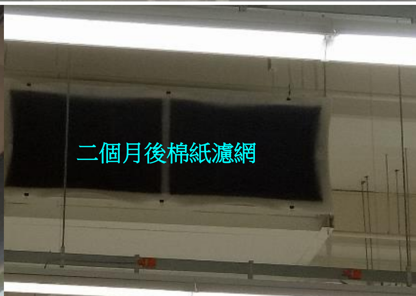
圖1.3 留意賣場（如家樂福）天花板懸吊空調箱的濾網狀況
