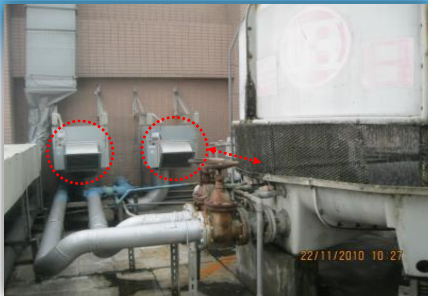
(a) 外氣入口靠近冷卻水塔
