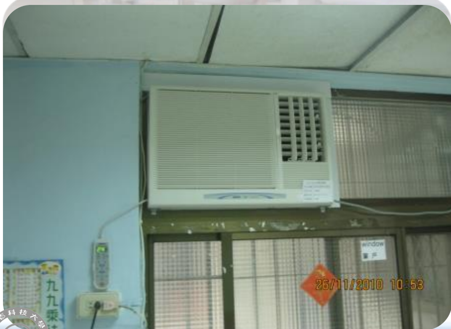
圖3.8 無外氣引入之內循環空調系統
