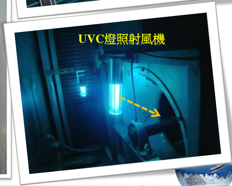
圖6.39 中央空調系統空調箱內UVGI淨化應用之實務案例
