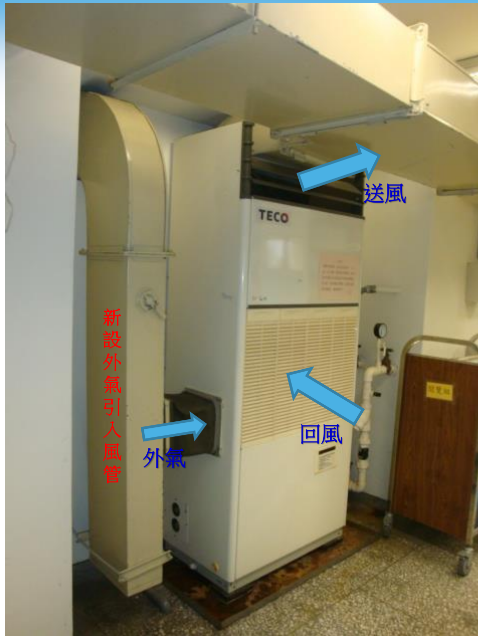
圖8.4 引入外氣直接進入落地型空調箱之改善案例
