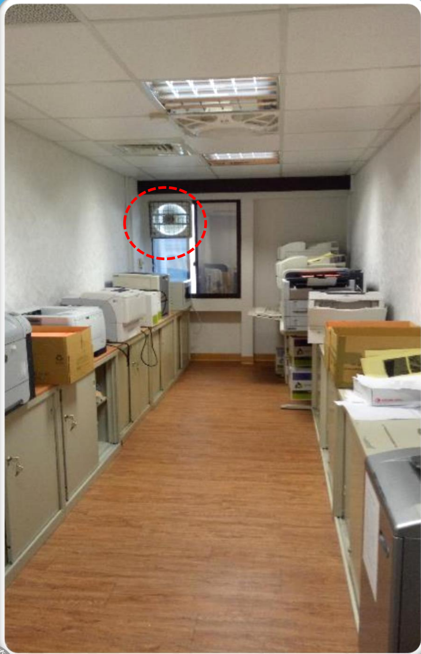
圖8.10 影印機獨立設置或採負壓排氣措施(續)
