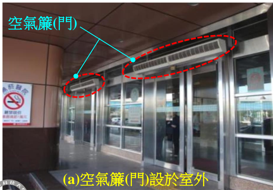
圖6.30 較佳的空氣簾(門)設置方式
