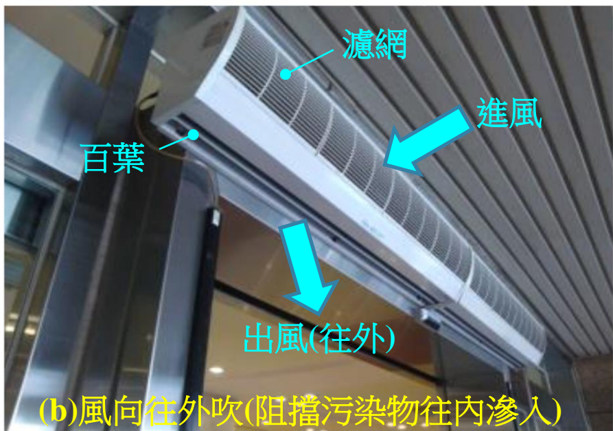
圖6.30 較佳的空氣簾(門)設置方式
