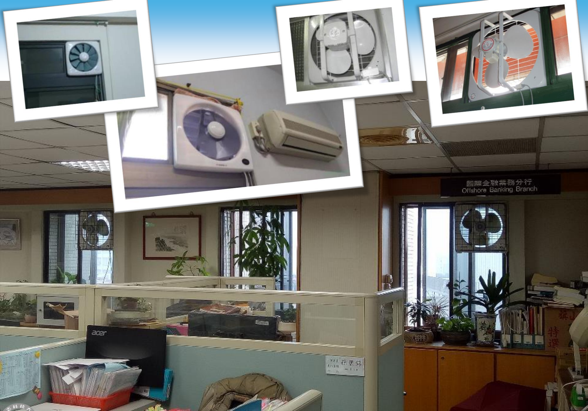
圖8.2 利用抽排風扇的簡易通風改善方式
