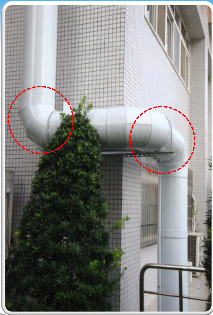
圖6.11 較佳(圓滑)的管線配置型態
