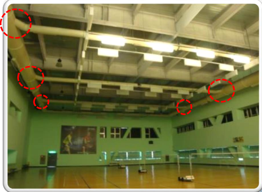
圖6.11 較佳(圓滑)的管線配置型態
